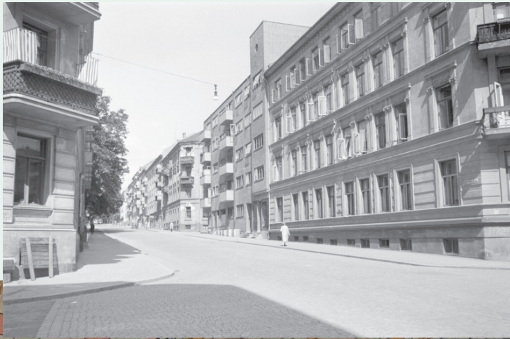
Funkis mellom murgårdene i Colletts gate 10
